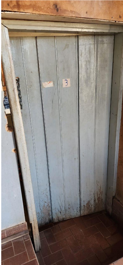
FOTO 7 – COZINHA – CAXILHO P03 DANIFICADA, SEM TRAVAMENTO EM UMA DAS LATERAIS, CORROSÃO DA MADEIRA E PINTURA DETERIORADA
