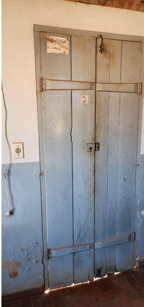
FOTO 6 – COZINHA – CAXILHO P02 DANIFICADA POR EXPOSIÇÃO A INTEMPÉRIES CLIMÁTICAS E PINTURA DETERIORADA
