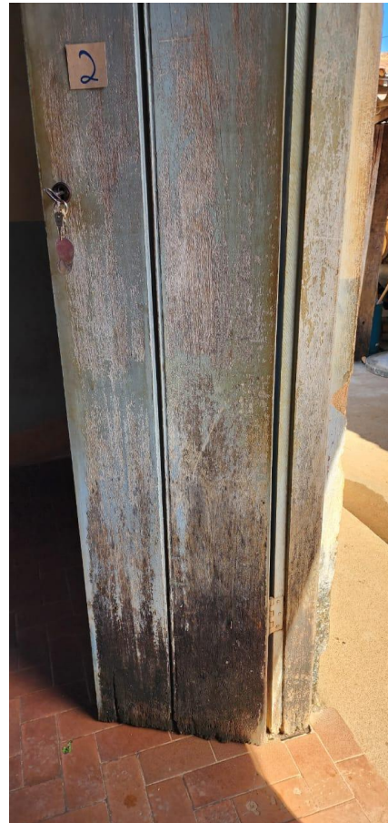
FOTO 6 – COZINHA – CAXILHO P02 DANIFICADA POR EXPOSIÇÃO A INTEMPÉRIES CLIMÁTICAS E PINTURA DETERIORADA
