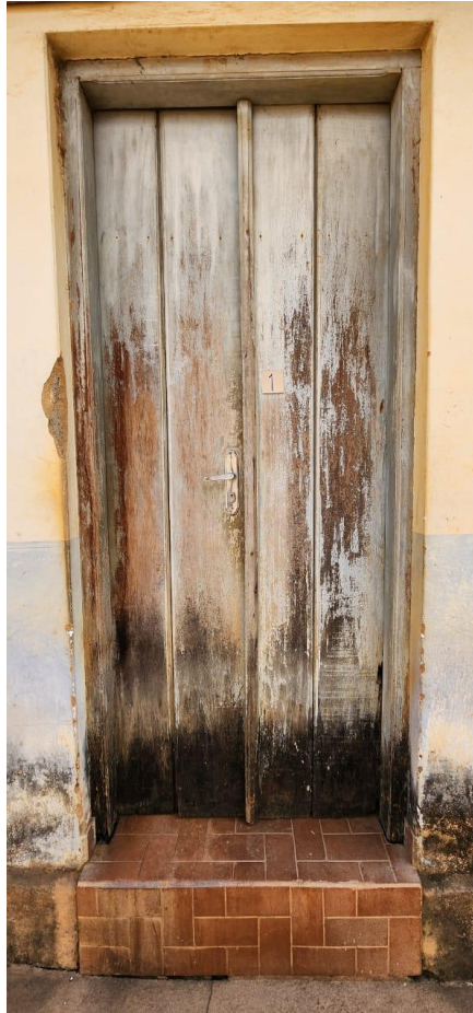
FOTO 5 – COZINHA – CAXILHO P01 DANIFICADA POR ATAQUE DE CUPINS, EXPOSIÇÃO A INTEMPÉRIES CLIMÁTICAS E PINTURA DETERIORADA
