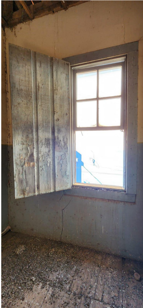
FOTO 46 – SALA 06 – CAXILHO J16 E J17 DANIFICADA E PINTURA DETERIORADA
