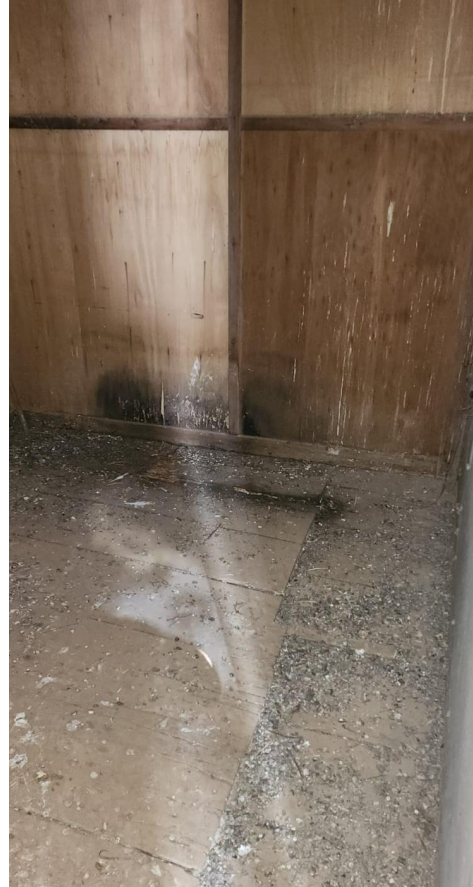
FOTO 55 – REMOÇÃO DO PISO DE MADEIRA PARA REAPROVEITAMENTO E REMOÇÃO DOS BARROTES DO PISO
