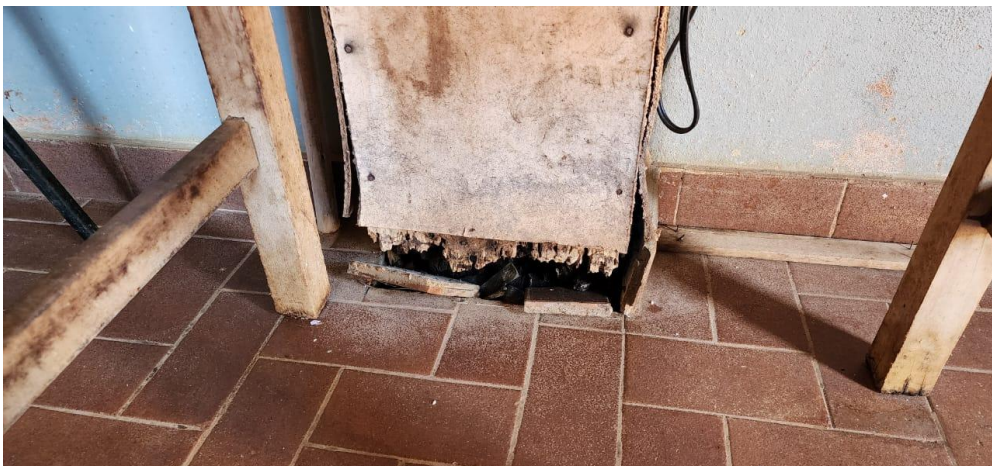
FOTO 57 – RECOMPOSIÇÃO DAS PARTES DANIFICADAS E SUBSTITUIÇÃO QUANDO NECESSÁRIO
