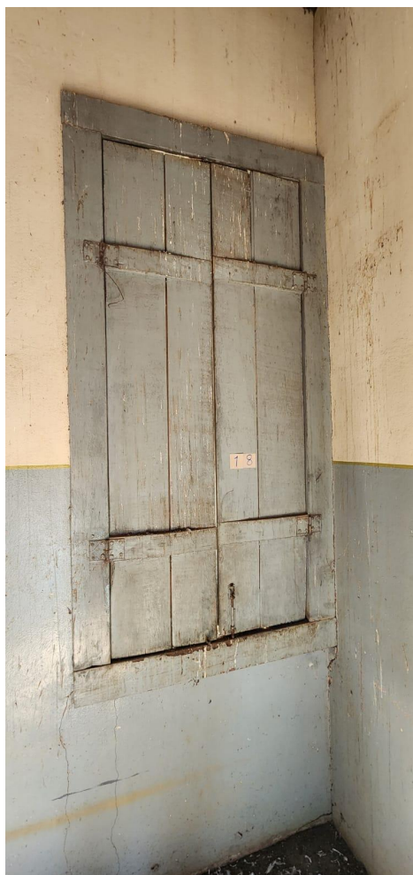
FOTO 44 – SALÃO 03 – CAXILHO J18 E J19 DANIFICADA, CORROIDA POR CUPINS E PINTURA DETERIORADA
