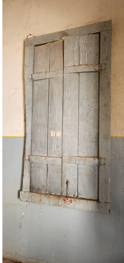
FOTO 46 – SALA 06 – CAXILHO J16 E J17 DANIFICADA E PINTURA DETERIORADA
