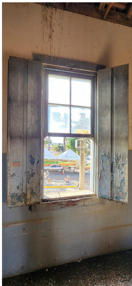
FOTO 44 – SALÃO 03 – CAXILHO J18 E J19 DANIFICADA, CORROIDA POR CUPINS E PINTURA DETERIORADA
