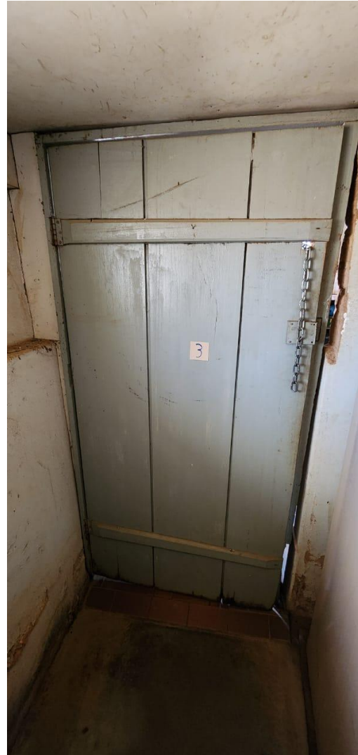
FOTO 7 – COZINHA – CAXILHO P03 DANIFICADA, SEM TRAVAMENTO EM UMA DAS LATERAIS, CORROSÃO DA MADEIRA E PINTURA DETERIORADA
