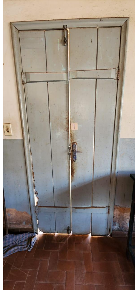
FOTO 5 – COZINHA – CAXILHO P01 DANIFICADA POR ATAQUE DE CUPINS, EXPOSIÇÃO A INTEMPÉRIES CLIMÁTICAS E PINTURA DETERIORADA
