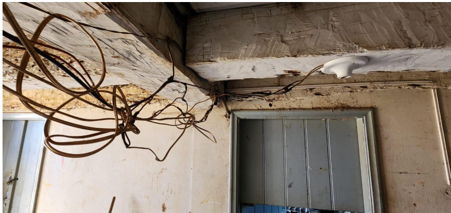
FOTO 59 – RECOMPOSIÇÃO DA REDE ELÉTRICA/ILUMINAÇÃO/SPDA/TELEFONIA/LÓGICA
