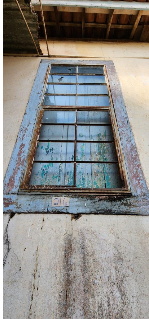
FOTO 54– SALÃO 03– CAXILHO J26 DANIFICADA, VIDROS QUEBRADOS, AUSÊNCIA DE ALGUNS VIDROS, ESTRUTURA DE FERRO QUEBRADA E PINTURA DETERIORADA
